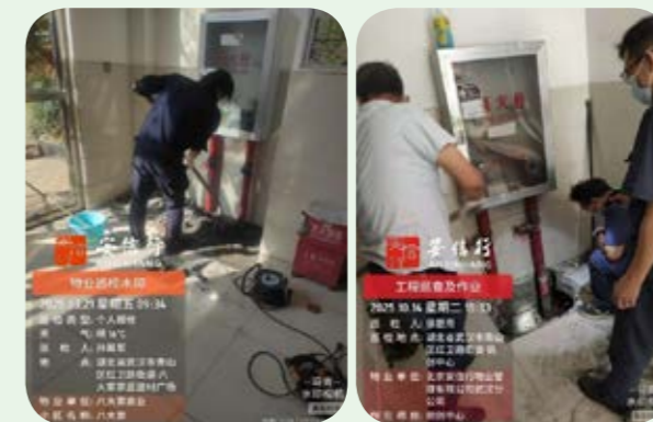
武汉 38 街小区隐蔽漏水点维修现场
