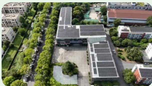
杭州昆仑工坊项目光伏应用照片
