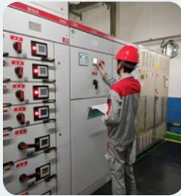
消防门检查维修
