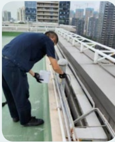
屋面弱电管线检修
